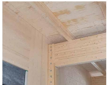
Kerto LVL Q-panel mit Stufenfalz als Mehrfeldträger Dachschalung.
