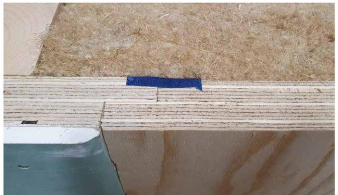
Abgeklebte Stufenfalzplatte mit Dämmung.
